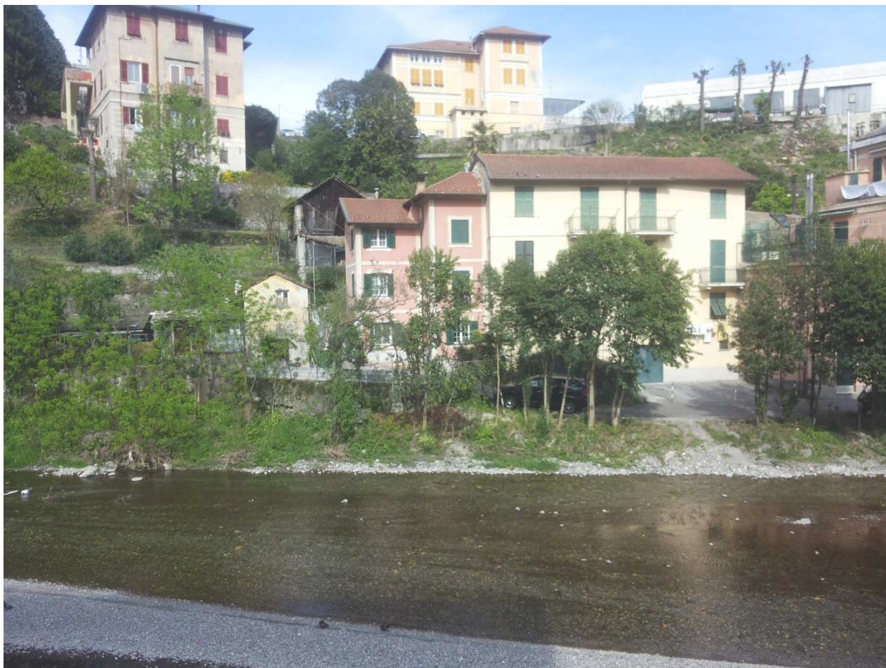
Foto 2 – fabbricati in sponda sx
