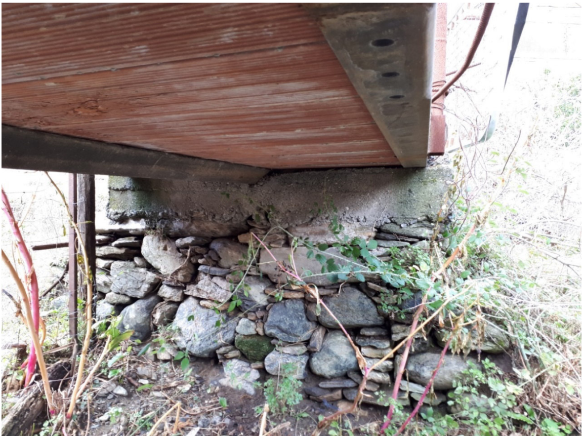
48-Spalla sinistra passerella.
