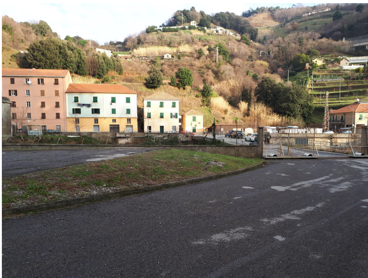
04-Area centrale E-distribuzione.
