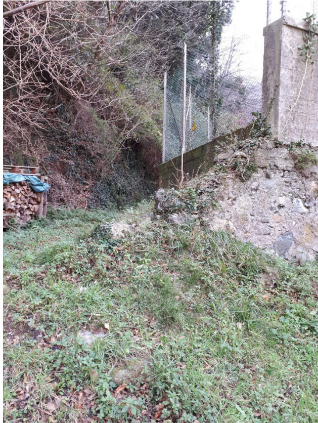
13-Terrapieno in alveo sottostante ponte sul lato valle-imbocco sentiero.
