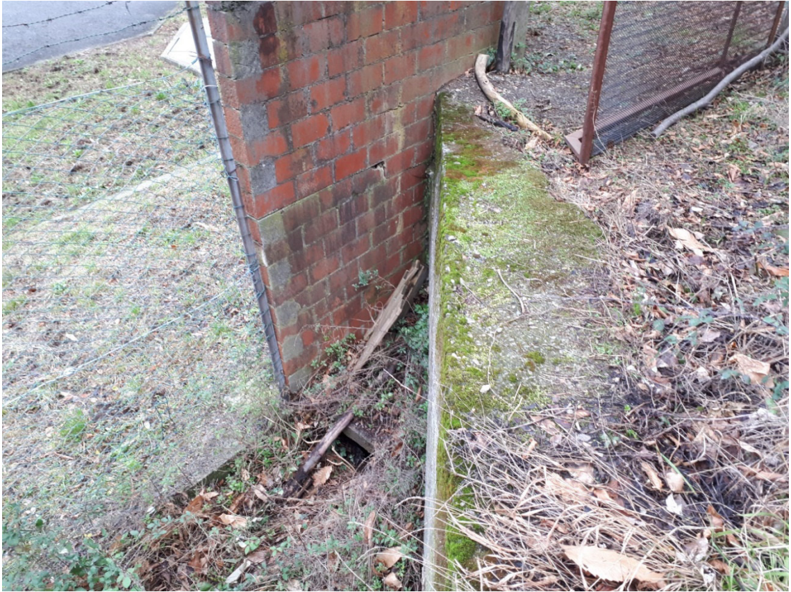
25-Salto di quota (in corrispondenza sezione 8): al piede del muro pozzetto raccolta acque.
