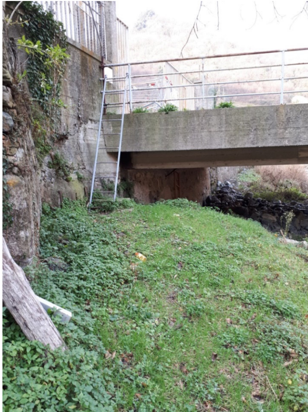
11-Terrapieno in alveo sottostante ponte sul lato valle.
