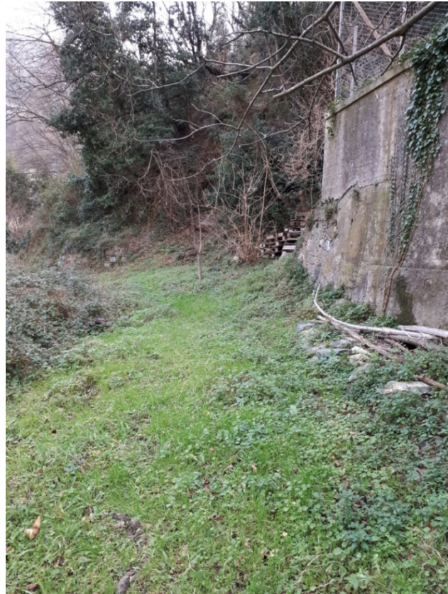
12-Terrapieno in alveo sottostante ponte sul lato valle.
