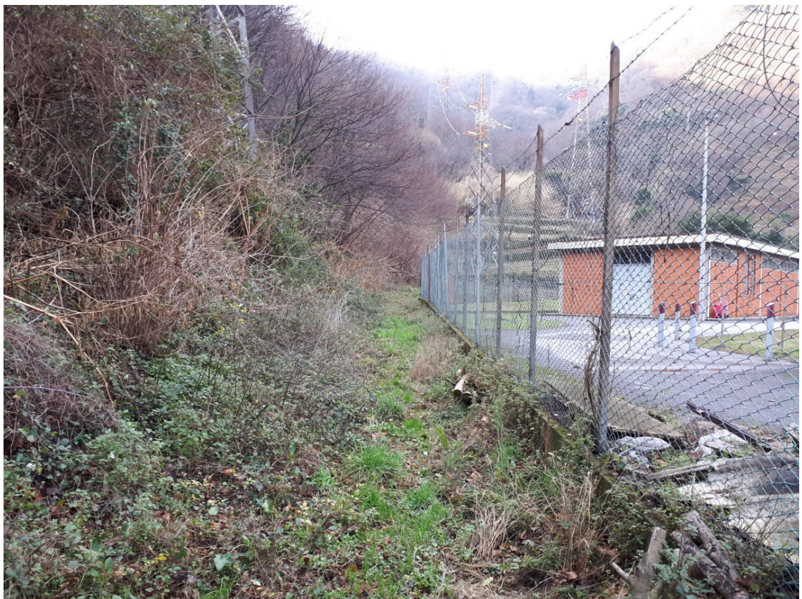
20-Prosecuzione sentiero al piede della scarpata.
