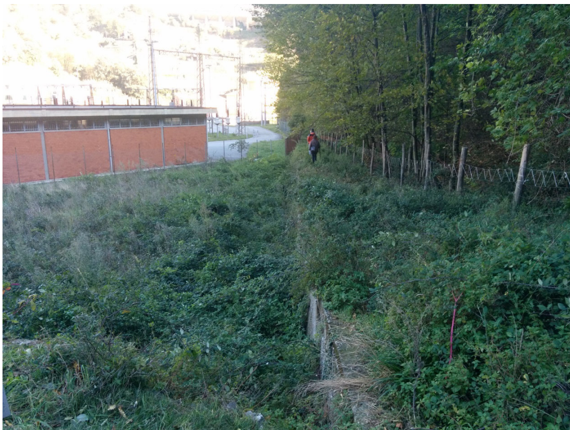
27-Muro a quota superiore rispetto campi: camminamento sopra testa muro.
