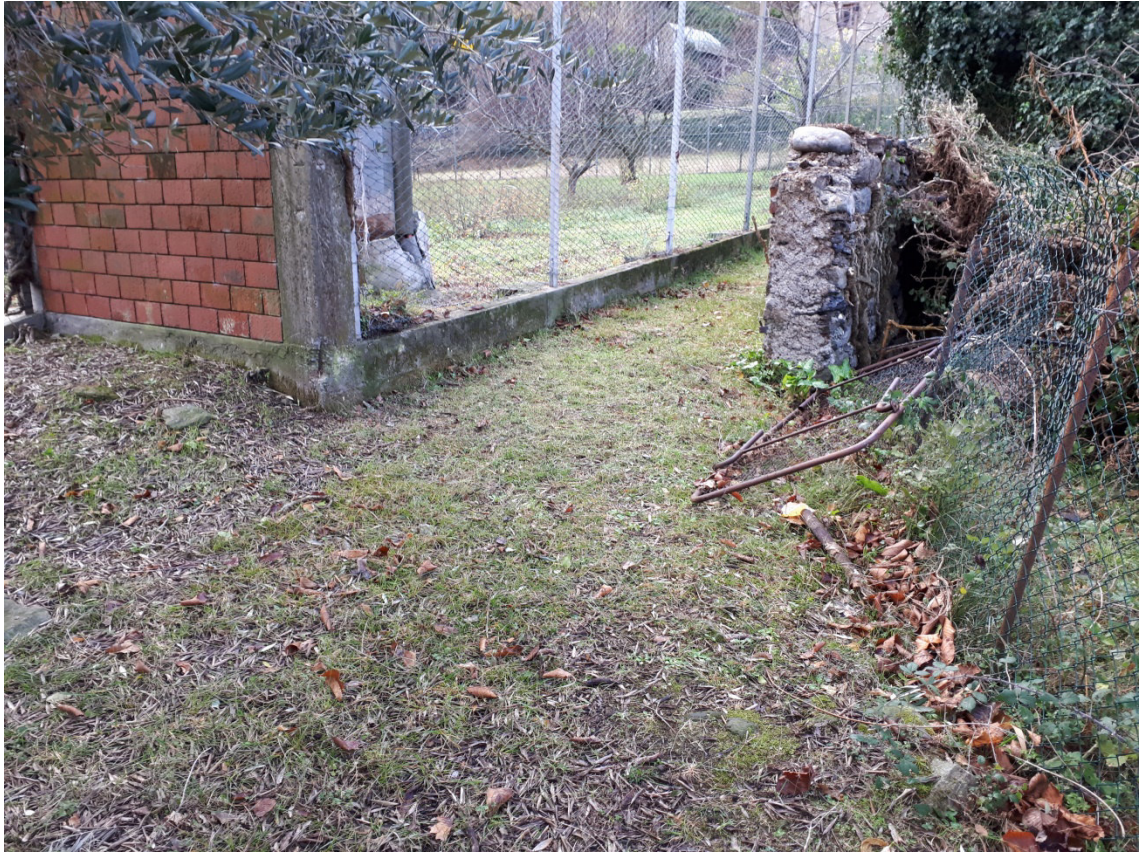
43-Parete di mattoni (Area Enel) e muro in pietrame in sponda destra al fosso (sezioni 22-23)
