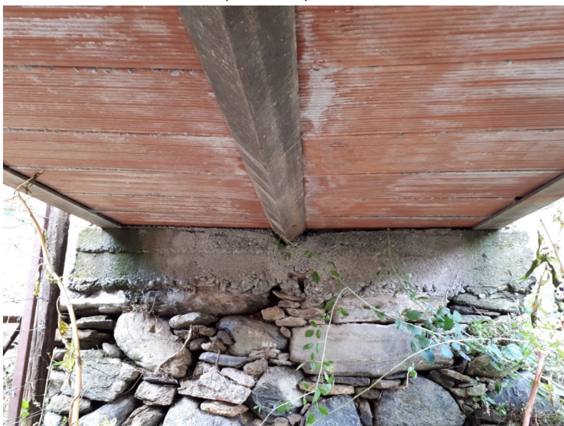
50-Intradosso passerella (vista verso spalla sinistra).
