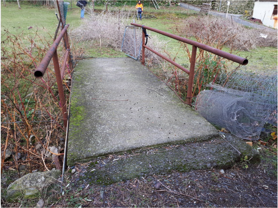
51-Percorso pedonale vista verso passerella pedonale.
