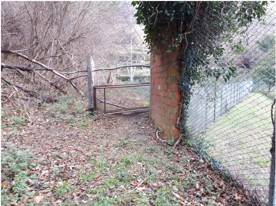
24-Parete in mattoni in corrispondenza salto di quota: cambio direzione cordolo portaringhiera.
