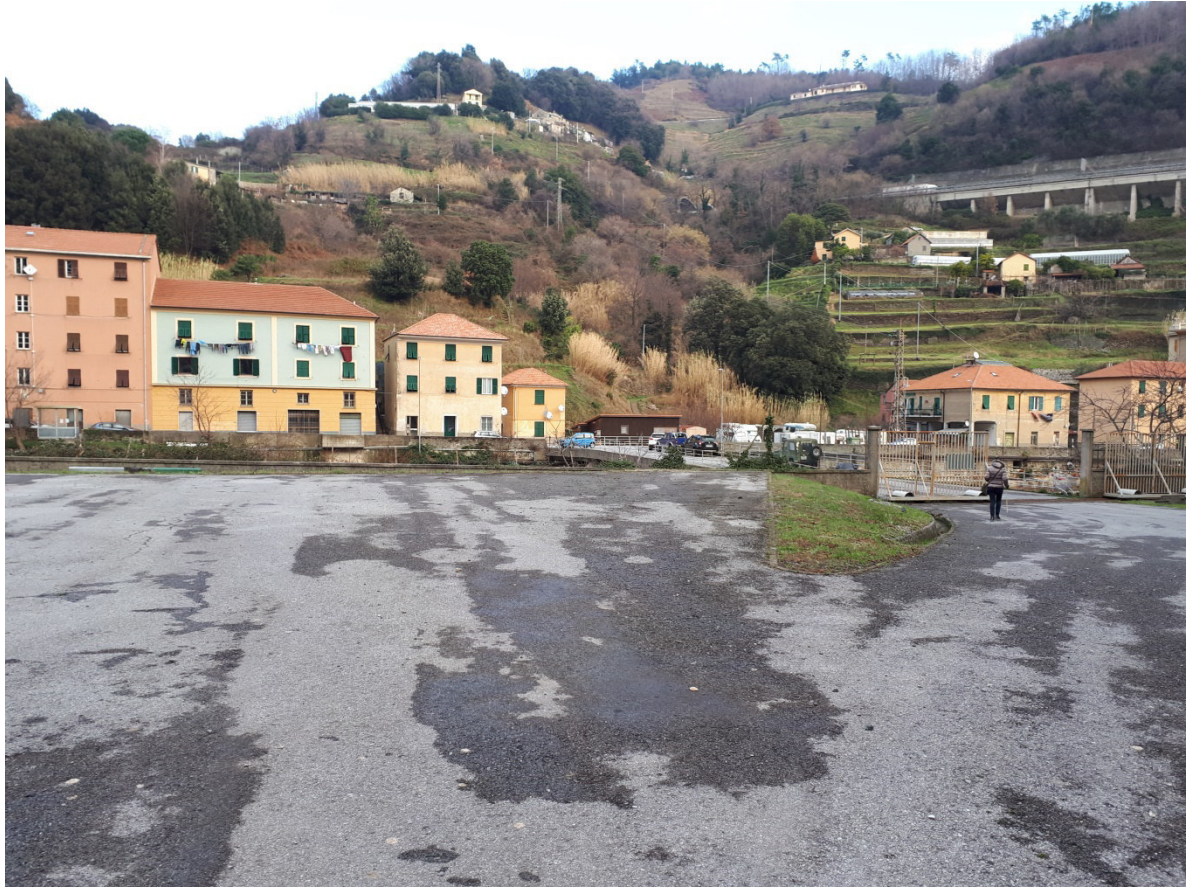
09-Area centrale E-distribuzione.
