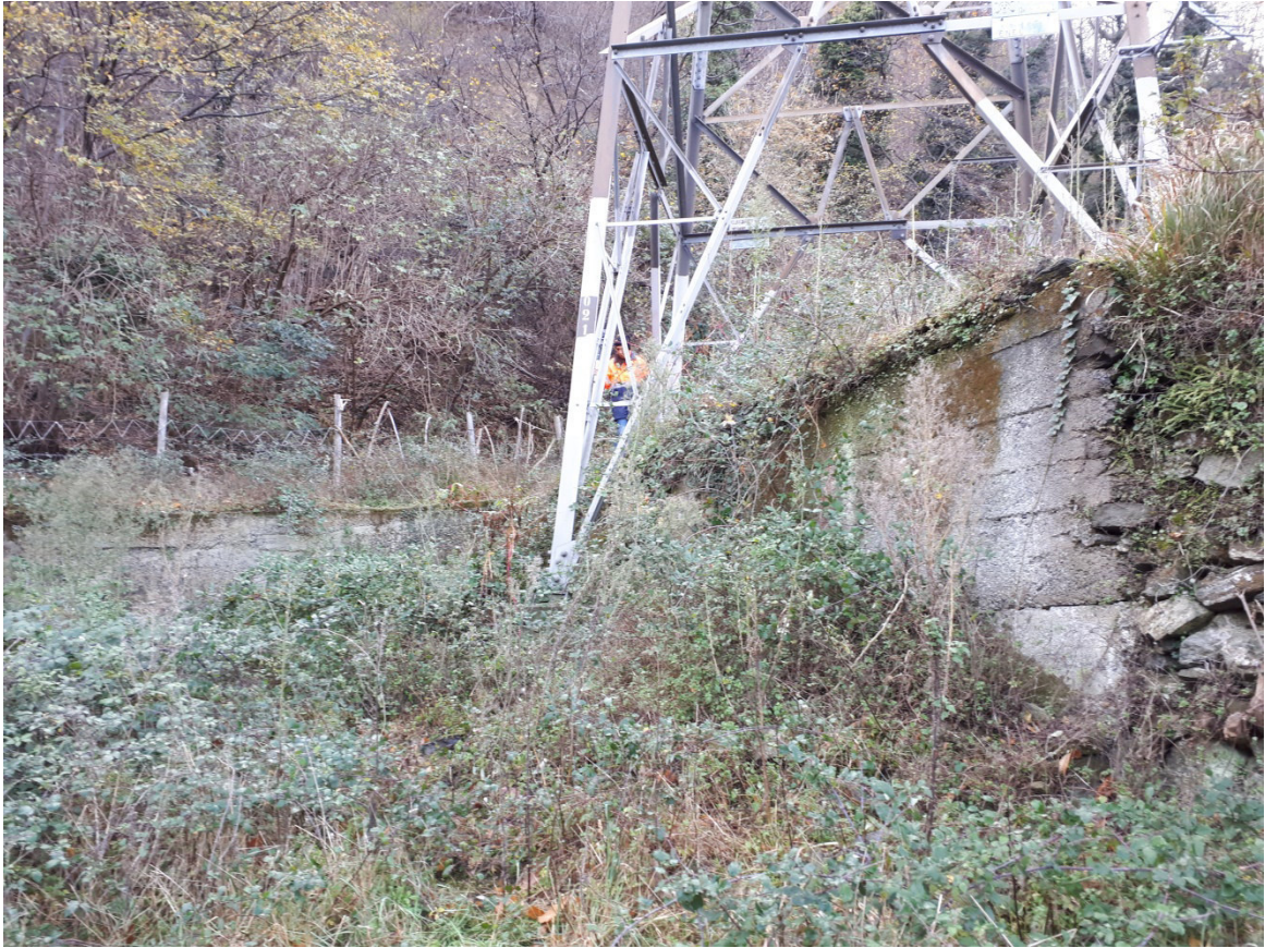
29-Muro in corrispondenza traliccio.
