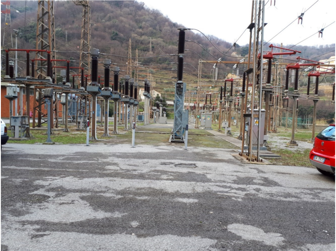
07-Vista piazzale centrale Enel, nel punto di accesso previsto.
