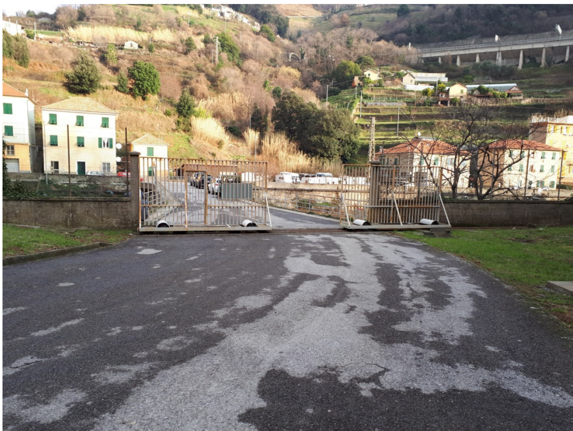
02-Cancello di accesso area E-distribuzione.
