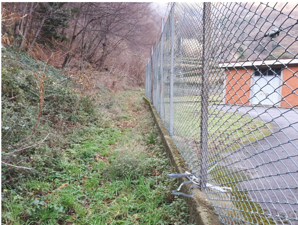
21-Prosecuzione sentiero: tratto in quota con piano calpestio area centrale E-distribuzione.
