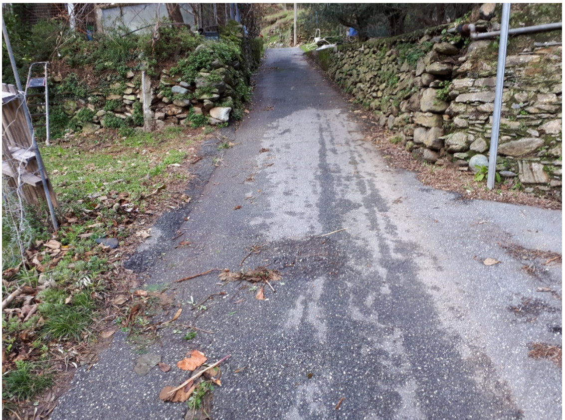
57-Via Chiale, vista verso civici a monte.
