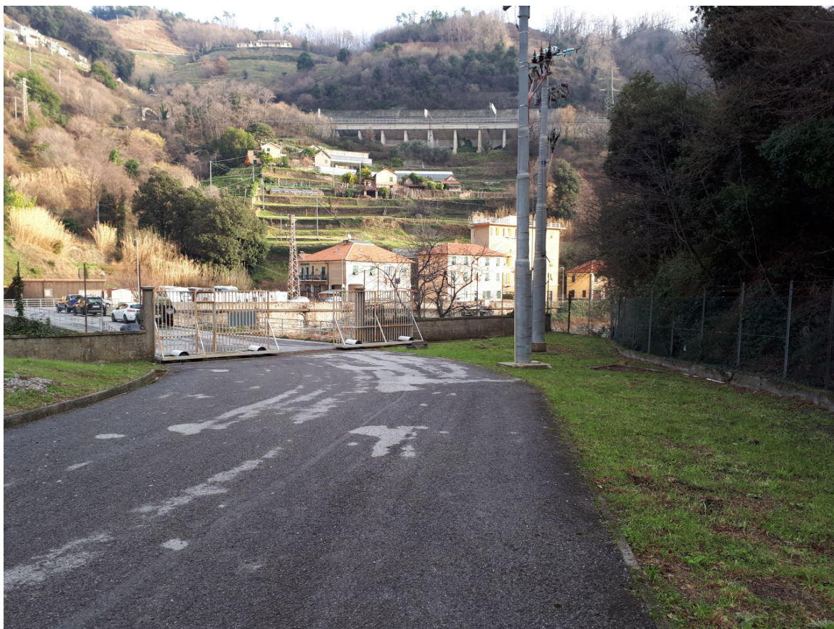
03-Cancello di accesso area E-distribuzione.
