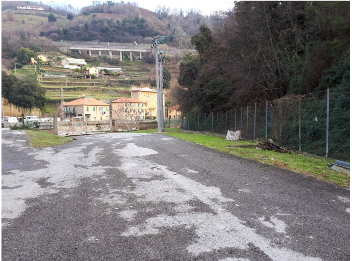
10-Area centrale E-distribuzione.
