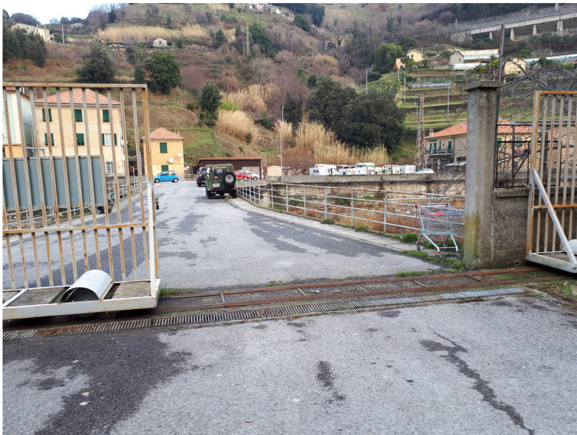
01-Ponte di accesso alla centrale elettrica.
