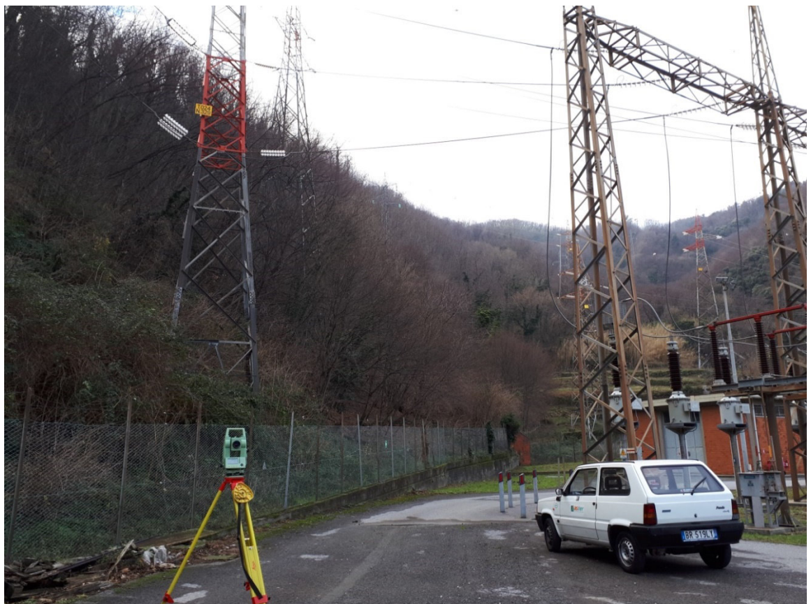
06-Area centrale E-distribuzione.
