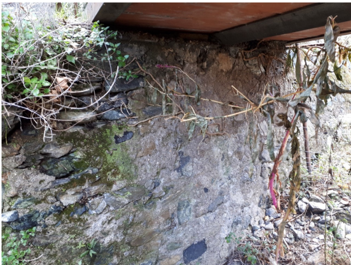
49-Spalla destra passerella.
