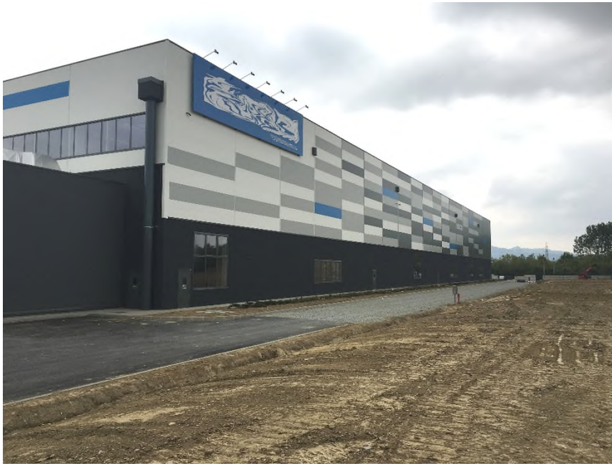
Immagine 2.3: esempio di pannello sandwich alternato a pannello prefabbricato in c.a.v. alla base (Copyright © 2016 TECHBAU. Tutti i diritti riservati)
