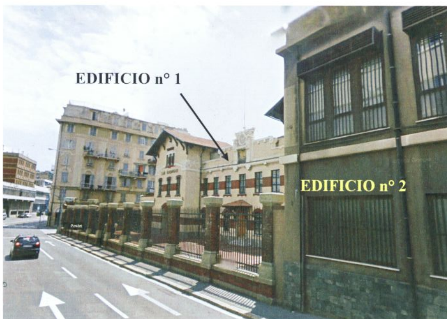
• - VISTA DEI FABBRICATI DA PONENTE -
